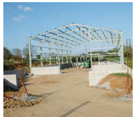
Construction du local technique, rue Michel Place
